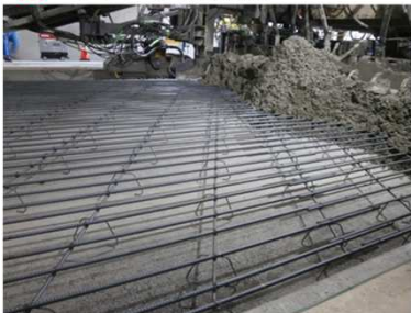
⑨ コンクリート 打設状況
