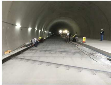
⑥ 主筋 設置状況
