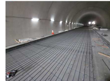
⑧ 配力筋S+主筋 組立完了
