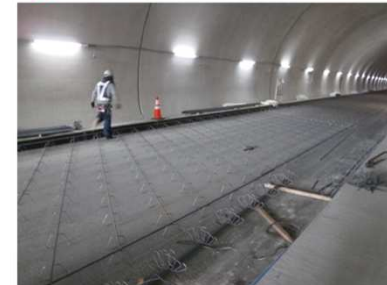
⑧ 配力筋S+主筋 組立完了
