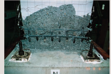
半円形フックの場合 かぶりコンクリートのはく落が大きい。
